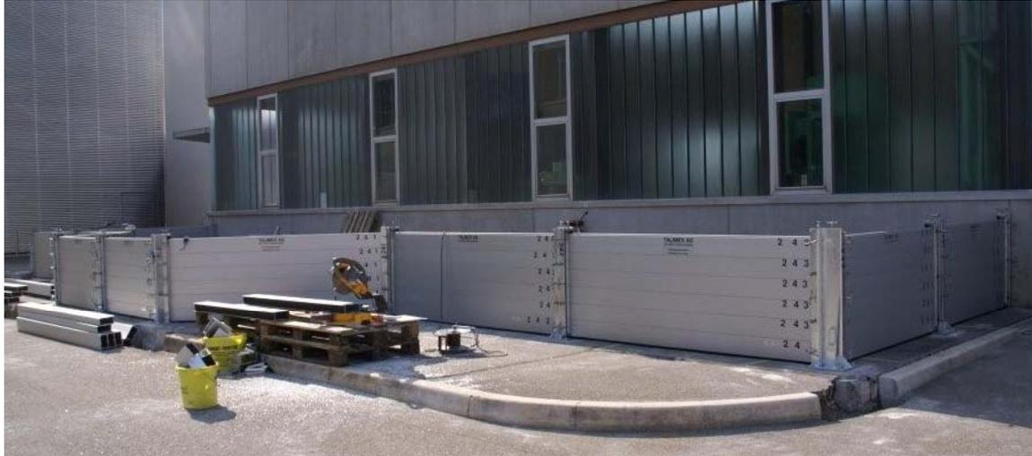
Mobile Hochwasserschutzwände zum Schutz des Pumpenhauses aussen...
