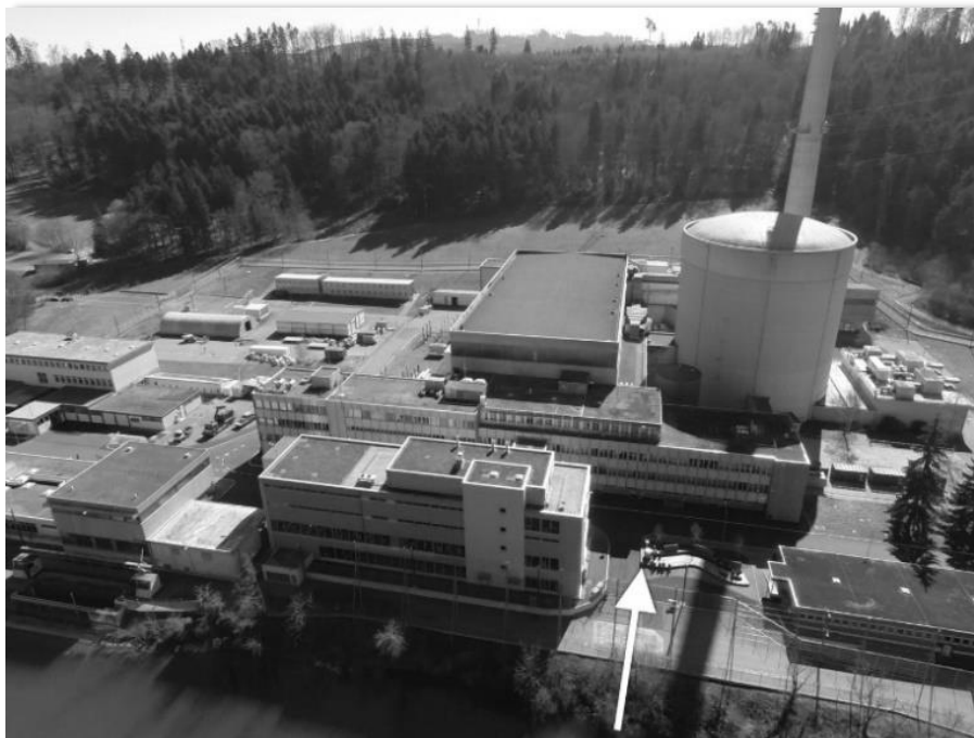
Bild: Einspeisestelle für den Anschluss mobiler Pumpen (Pfeil). Im Hochwasserstörfall wird diese Stelle ca. 50cm tief überflutet sein.
